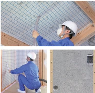
吹込み工法の最大のメリットは、手の届かない小さな隙間にもセルローズファイバー断熱材をしっかりと充填できることです。設計により計算された断熱性能を、現場施工において実現することができます。
